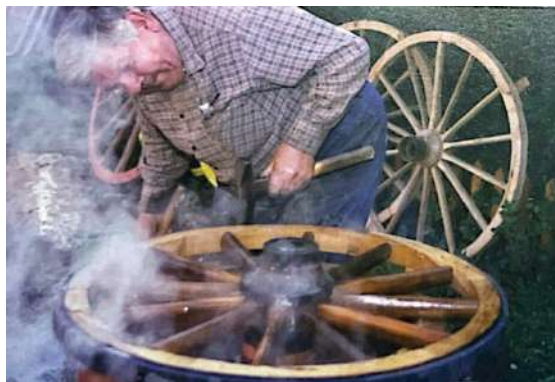
Figura 24: Joaquim Duran Estarriola ferrant una roda de carro. Font: Oficis i feines d'abans (p.226).
