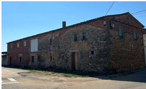
Figura 15: Casa vella de ca n'Ordis. Font: elaboració pròpia.
