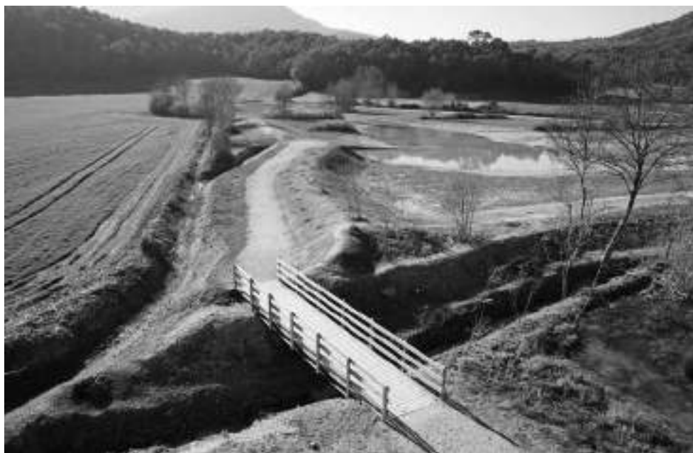
Figura 1. Vista aèria de la llacuna d'en Margarit, un cop finalitzades les obres (gener de 2007).
